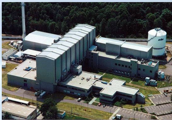
欧州遷音速風洞 (2mX2m) 世界最大の 高レイノルズ数風洞 実質の世界標準 (欧州)
